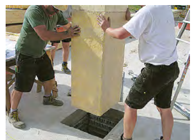
Abb. 6.3 Einbau einer unmittelbar in Stahlbetonfundamente eingespannten BS-Holz-Stütze
