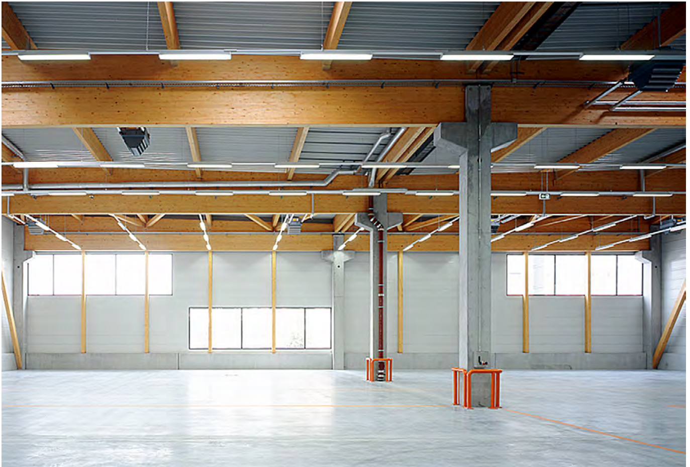
Abb. 1.3 Logistikzentrum mit Haupt- und Nebenträgern aus BS-Holz
