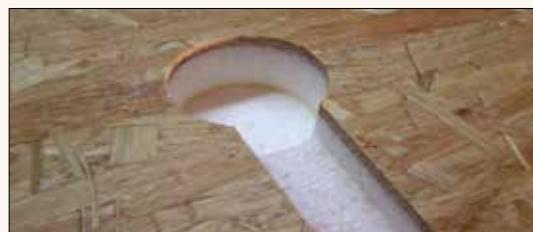
Installationsfräsungen
