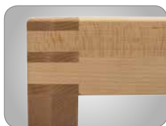
Fingerverzinkung in Hinterzange und Beiladerücken
